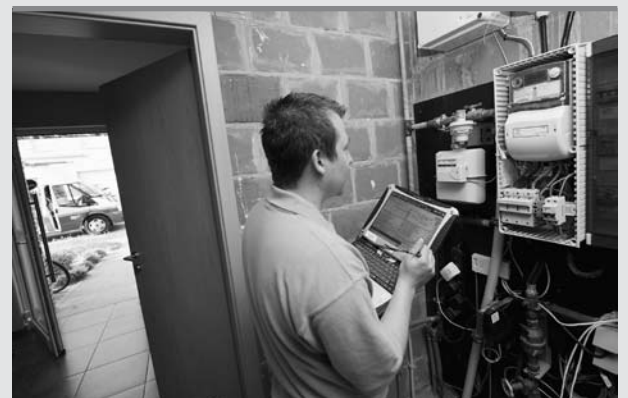
installatie van de slimme meter (foto Eandis)
